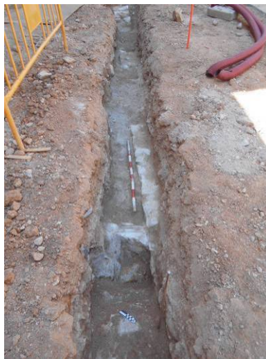
Fonamentacions UE 248 i 249. Vista des del nord-est.
