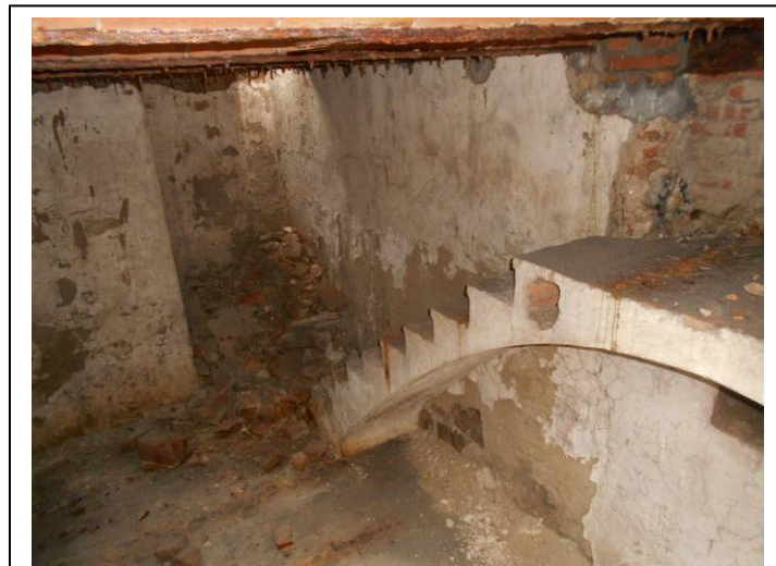
Interior del soterrani (UE 236). Vista des de l'oest.
